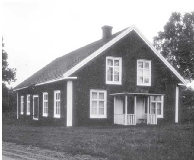
Värmeshults Missionshus i Gällaryds socken i Småland, byggt 1876. Foto: Klas Börjesson.
